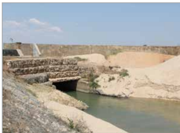
Voici un exemple d'ensablement d'un canal d'irrigation à Bevoay
