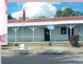
Le bâtiment abritant la PP Andapa
