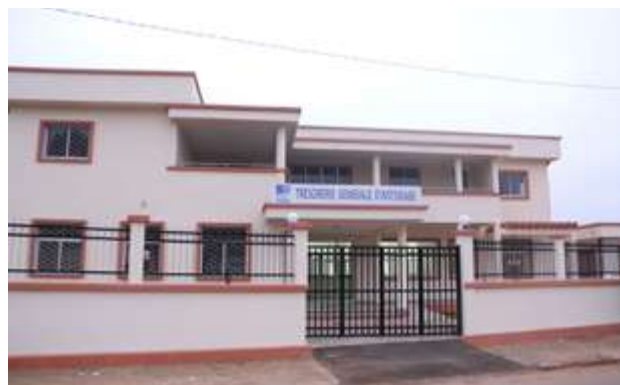
Nouveau bâtiment de la Trésorerie Générale d'Antsirabe
